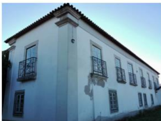
Residência de Estudantes da ESPROARTE, fachada exterior.
